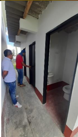
Construcción de servicios sanitarios y área de maquinaria y/o herramientas
