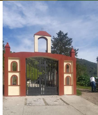
Mejoramiento de cerco perimetral y portería
