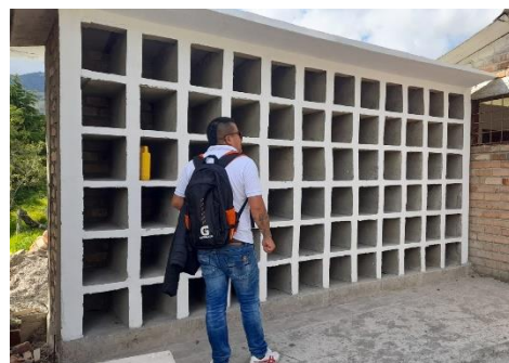
Construcción de osarios
