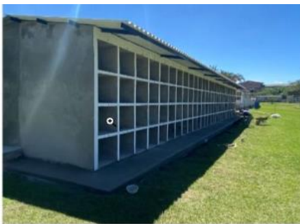
Construcción de bóvedas
